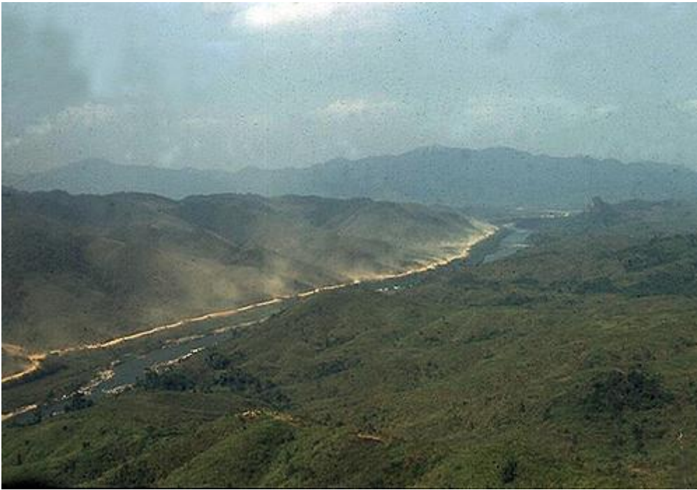
Đoạn đường mới mở gần căn cứ Bravo
