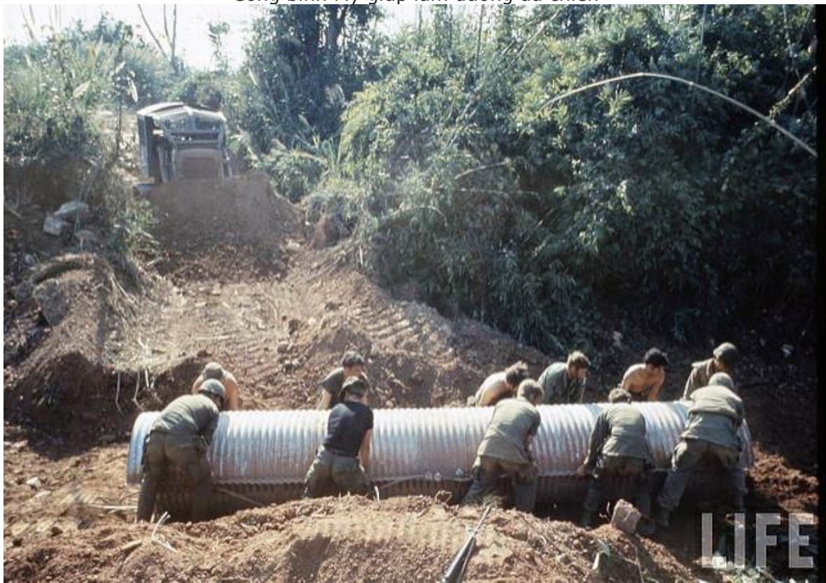
Con đường do Lực lượng Công binh vừa làm xong
