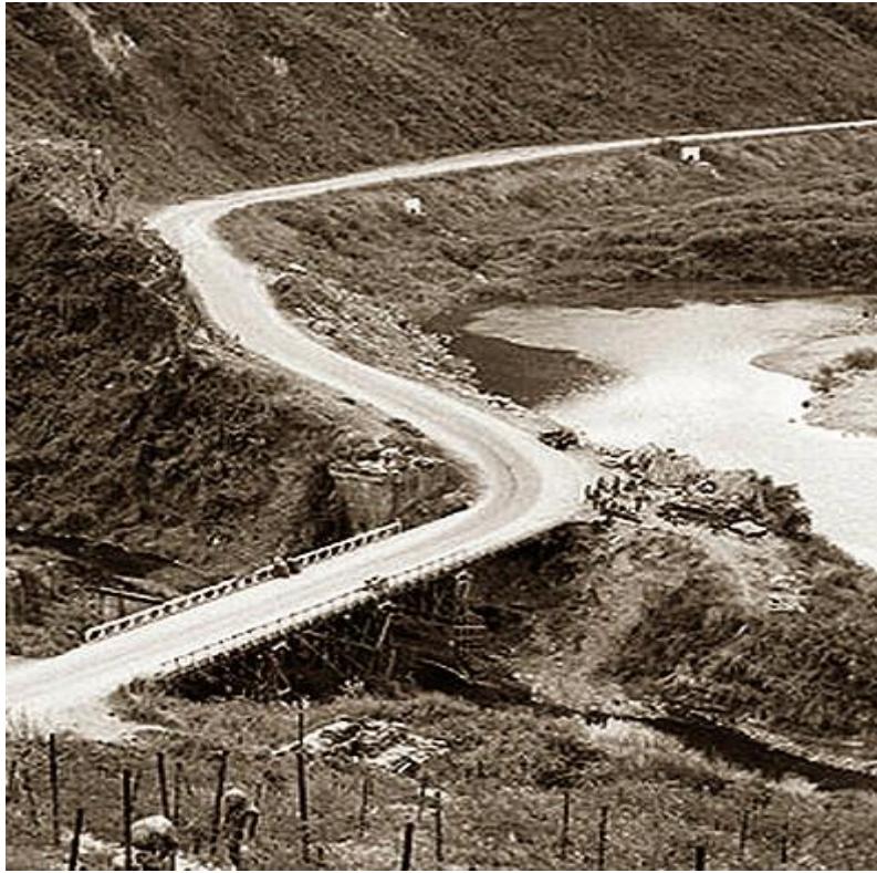
Một con đường phụ chạy song song QL9 vừa được lính công binh Hoa kỳ xây dựng nhằm phục vụ cuộc hành quân Lam Sơn 719 , trong ảnh cho thấy địa thể con đường nhò rất hiểm trở
